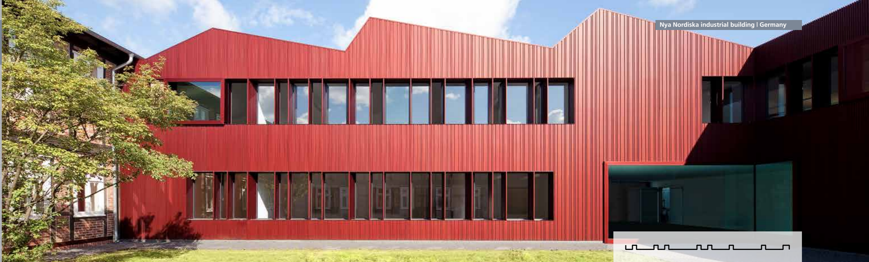
Profilo irregolare speciale SQ-20/20-R, AlMg1, Sandalor® anodizzato
