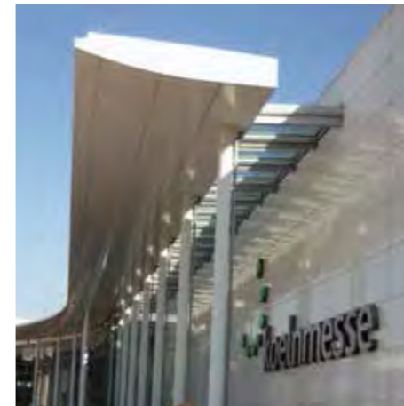
Nuove sale espositive, Colonia: Rivestimento in poliestere AlMg di alta qualità
