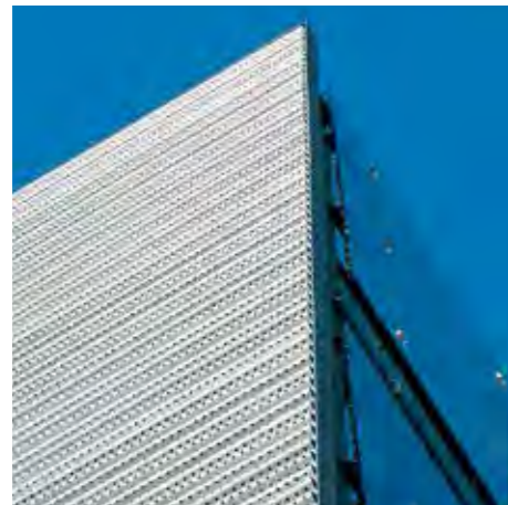
Tettoia con giunti di testa di precisione per la zona di ingresso del Centro per l'Arte e i Media ZKM di Karlsruhe
