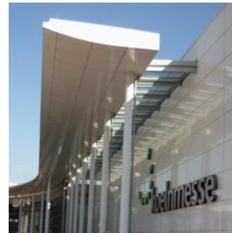
Nouveaux halls d'exposition à Cologne | Allemagne Revêtement avec enrobage polyester AIMg haut de gamme
